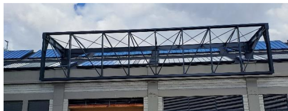
Crédit photo : SOPREMA Entreprises / Charpentes FOURNIER / SOTEBA-RSR
